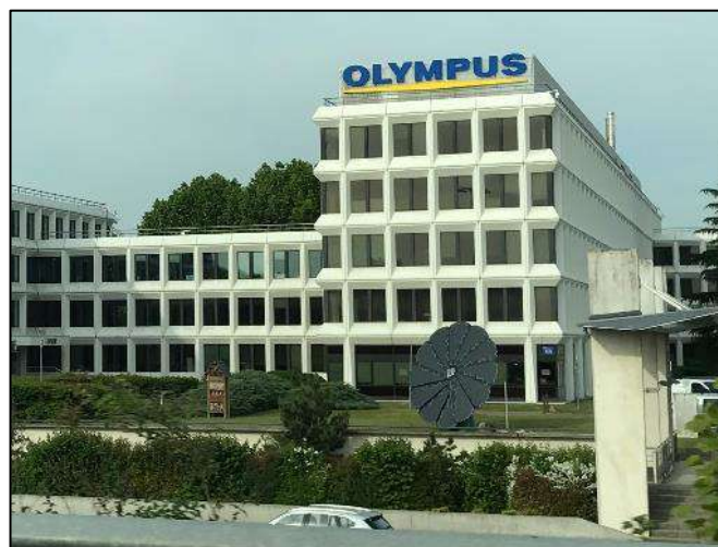
Exemple d'enseigne en toiture sur le parc d'activités Icade Paris-Rungis - Source : Even Conseil, 2019
