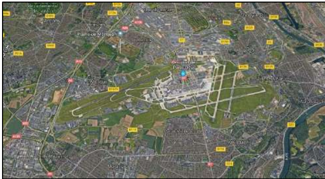
Vue aérienne de l'aéroport d'Orly et de la zone d'activités de Rungis – Source : GoogleMap
