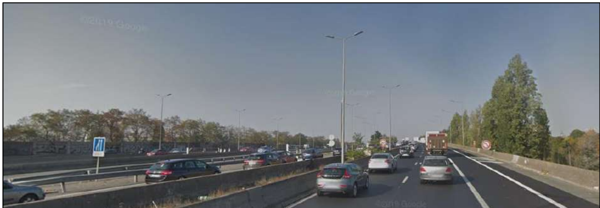
L'autoroute A6, au niveau de la commune de l'Hay-les-Roses – Source : Google Streetview
