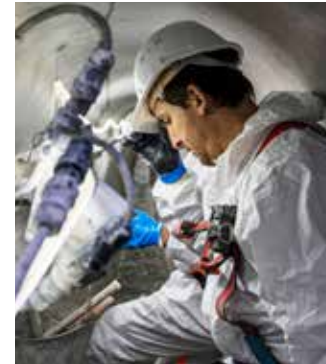
Inspection d'un ovoïde par un technicien de l'assainissement à Vitry-sur-Seine
