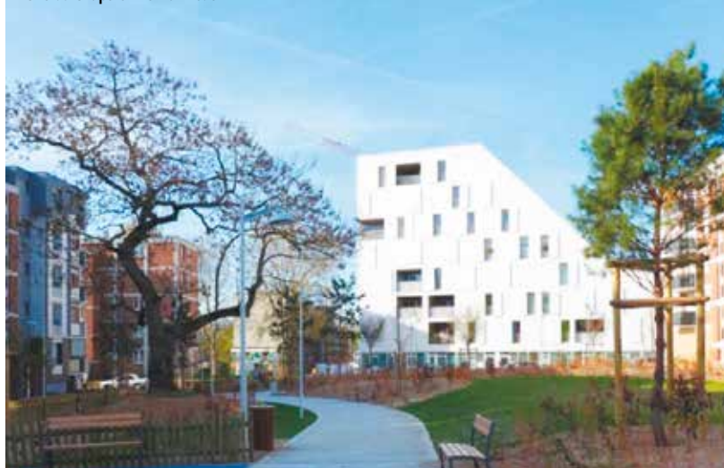
Cité du Chaperon vert à Arcueil
