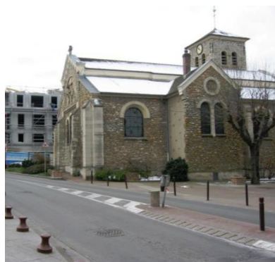
Vue du transept et de la nef de l'église Saint-Eloi
