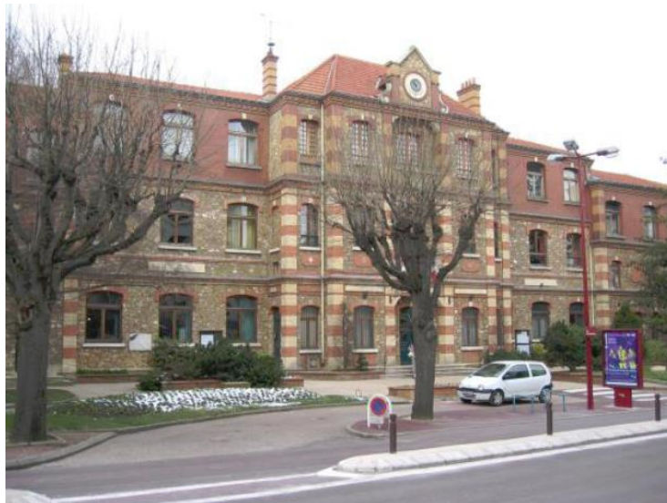
Vue de la mairie de la place de l'église
