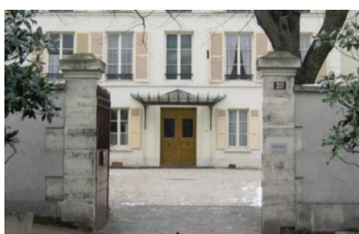
Détails de la porte d'entrée et du auvent de la maison
