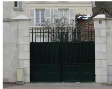
Détails du portail d'entrée de la maison
