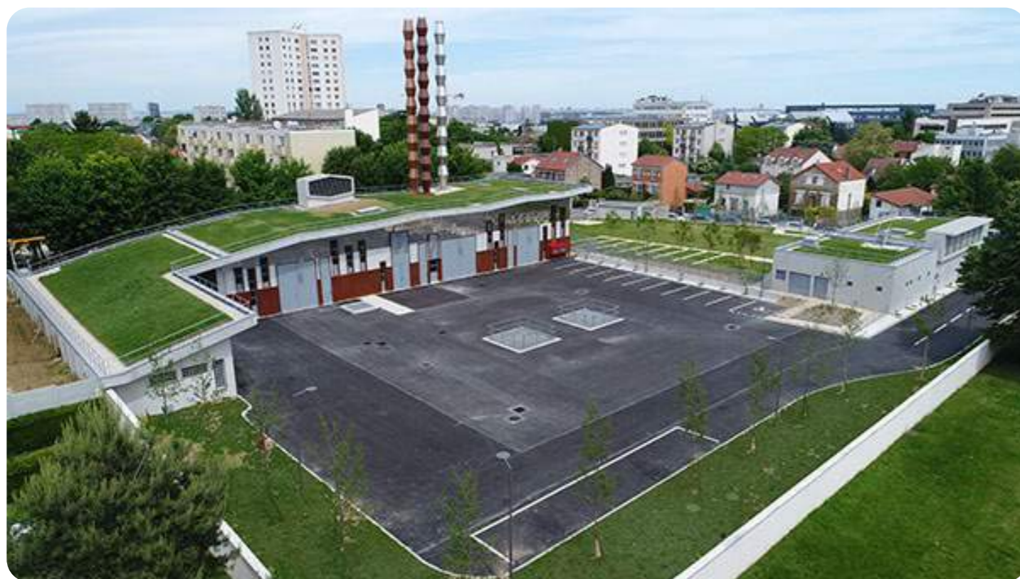
Centrale géothermique de Villejuif (source Semhach, 2023)
