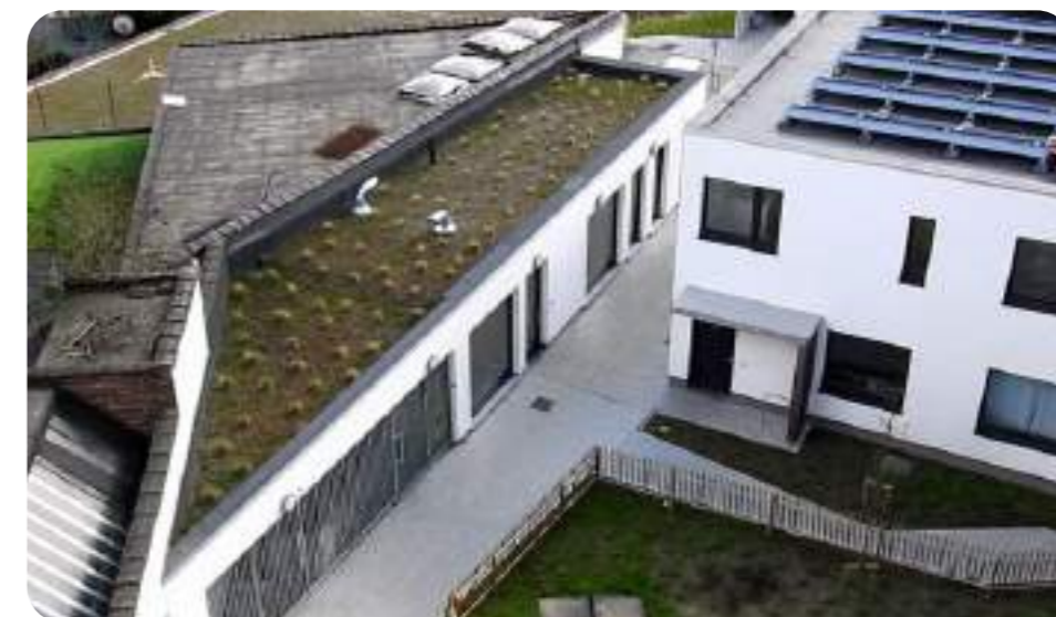
Les toitures des bâtiments peuvent servir de surfaces de collecte d'eau. Parmi les systèmes de récolte de l'eau de pluie existantes : les toits avec EPDM sur lesquels sont installés des panneaux photovoltaïques et les toitures vertes extensives. (source : Guide bâtiment durable.brussels/© Ecorce 2023).
