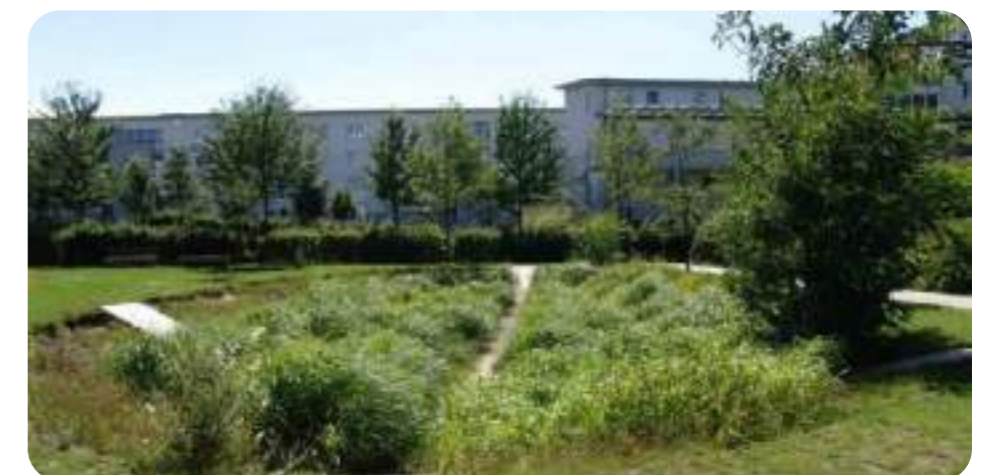
Exemple de bassin d'infiltration sec (Bruxelles Environnement, 2018)
