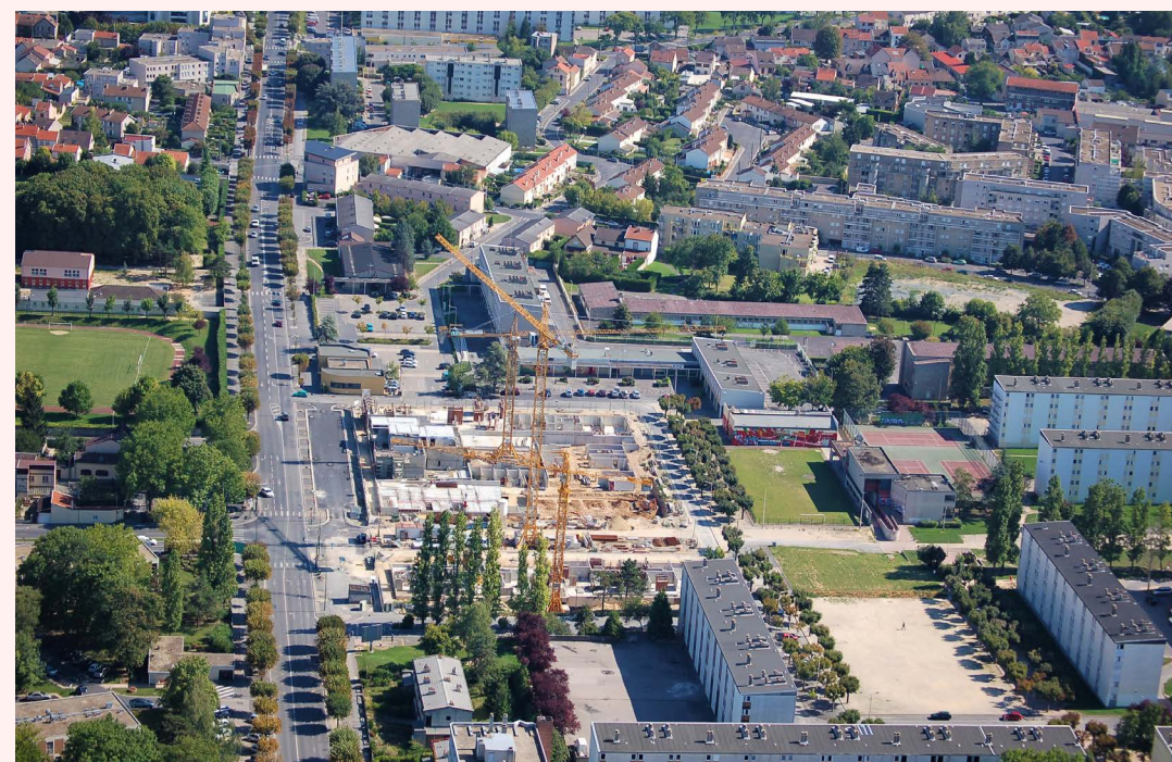
Reims, quartier en chantier de renouvellement urbain
