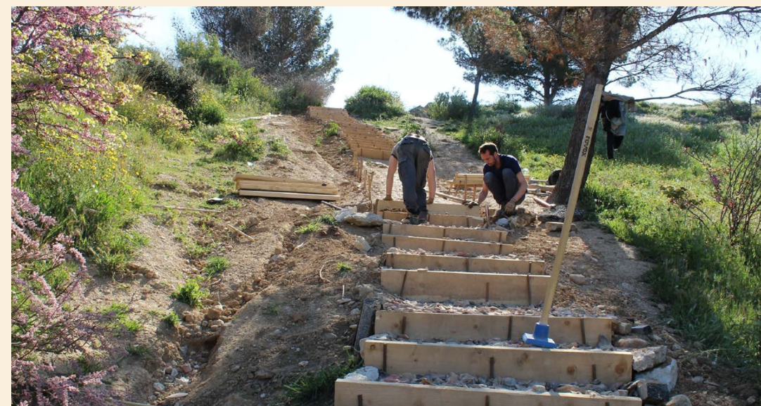
Construction de l'escalier
