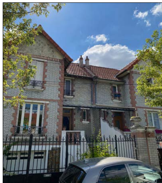
MAISONS JUMELLES 16 et 18 rue Pompadour
