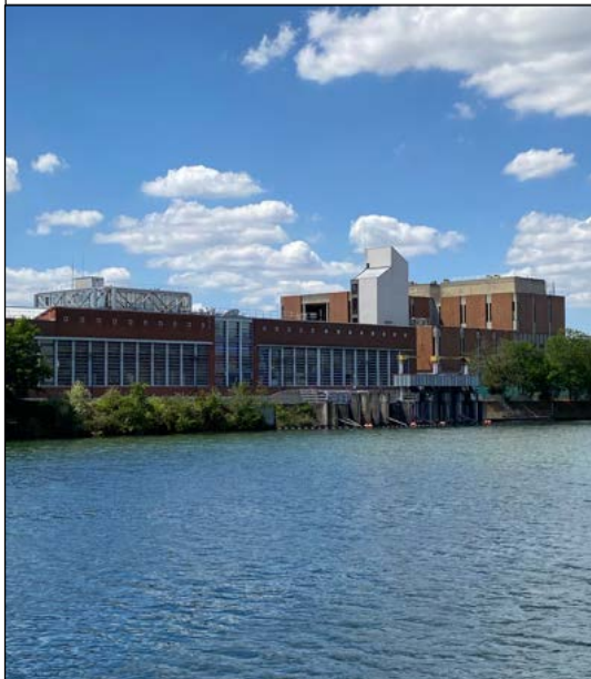
BÂTIMENT INDUSTRIEL 28 avenue Guynemer
