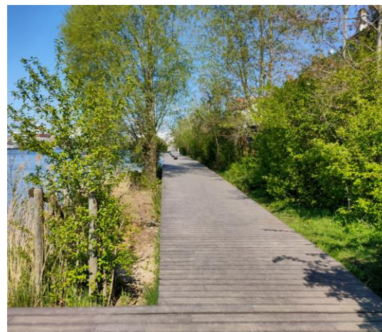
Aménagement platelage en bois – Choisy-le-Roi
