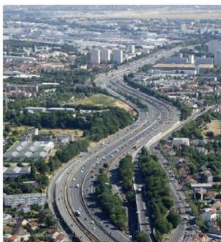
Emprise de l'autoroute A6 à L'Hay-les-Roses
