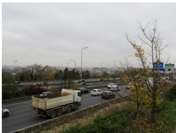
Autoroute du soleil (A6) passant à l'Est de Villejuif, vue depuis le parc des Hautes Bruyères (Even Conseil)
