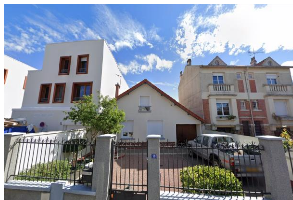
Formes bâties aux architectures diversifiées, mêlant maisons traditionnelles à maisons modernes, à Chevilly-Larue (Google Maps)
