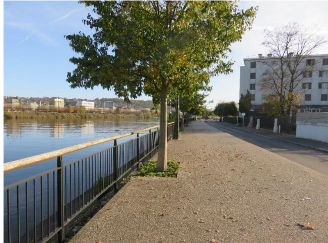
Berges artificialisées mais végétalisées à Villeneuve-le-Roi (Even Conseil)
