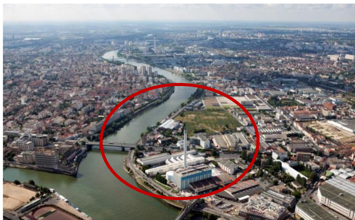
Usine de la Compagnie Parisienne Urbaine de Chauffage (CPCU), Ivry-Sur-Seine (Institut Paris Région)
