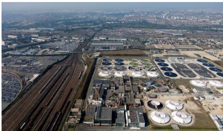
Station d'épuration de Valenton (Institut Paris Région)
