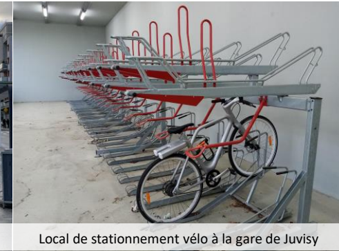
Local de stationnement vélo à la gare de Juvisy
