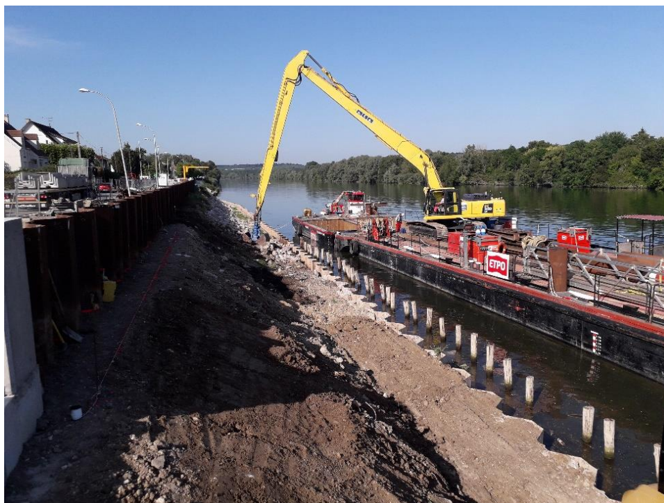
Figure 46 : Travaux sur la digue de Sartrouville à Montesson (source : SMSO)
