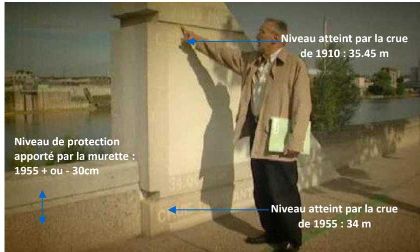
Figure 18 : Murette anti-crues, quai Jules Guesde, Vitry Sur Seine (94). Source : EPTB Seine Grands Lacs
