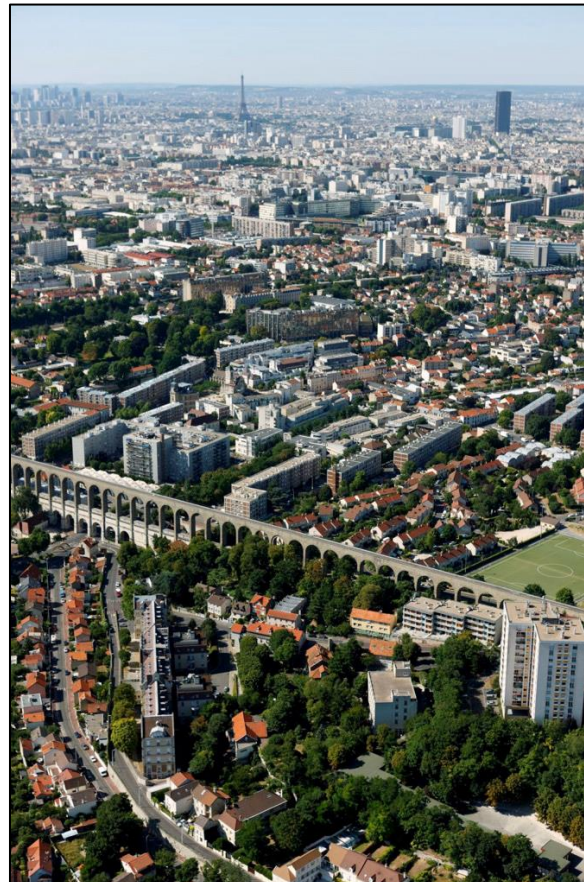
Aqueduc de la Vanne et du Loing à Arcueil – Source : APUR
