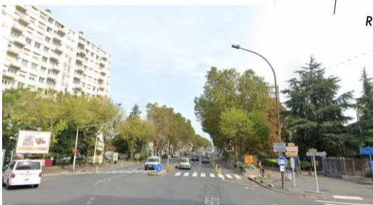
RD 920 à Cachan. Source : Google Streetview
