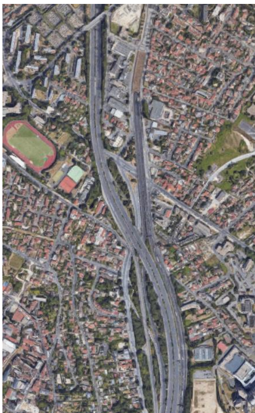
Le secteur des 4 chemins entre Arcueil, Cachan et Villejuif, où se rejoignent les autoroutes A6a et A6B.
