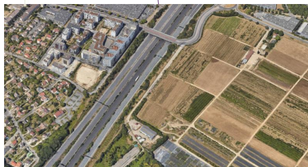
A 86 à Fresnes. Source : Google Satellite
