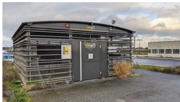
Athis-Mons : en face du Terminus du T7, places de stationnement vélo abritées, fermées, et placées sous vidéo protection
